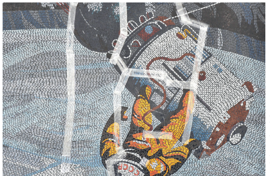
Mosaikbild 3 – Ablösungsfläche mit Riss und Versatz in der Bildebene nach der Notsicherung durch Sicherungsstreifen aus Japanpapier bzw. Glasfasernetz
